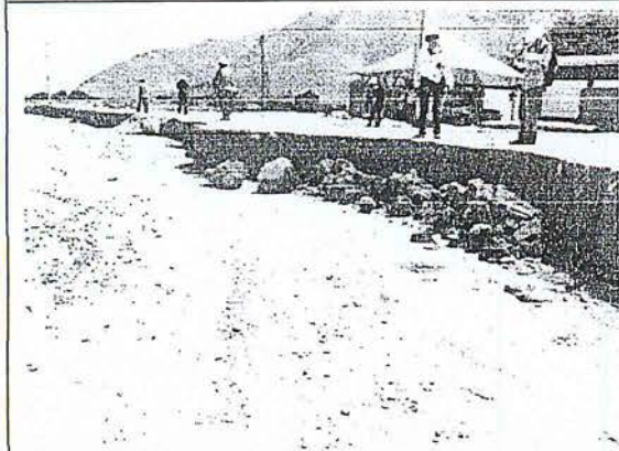
Erosión lateral del margen derecho del río que pone en riesgo la caseta de bombeo existente. Incremento del cauce del río ganándole terreno a las áreas de cultivo aledañas al cauce.
